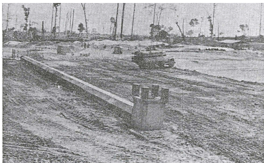
รูปที่ 9-10 งานก่อสร้างท่อระบายน้ำจากอ่างเก็บน้ำ
